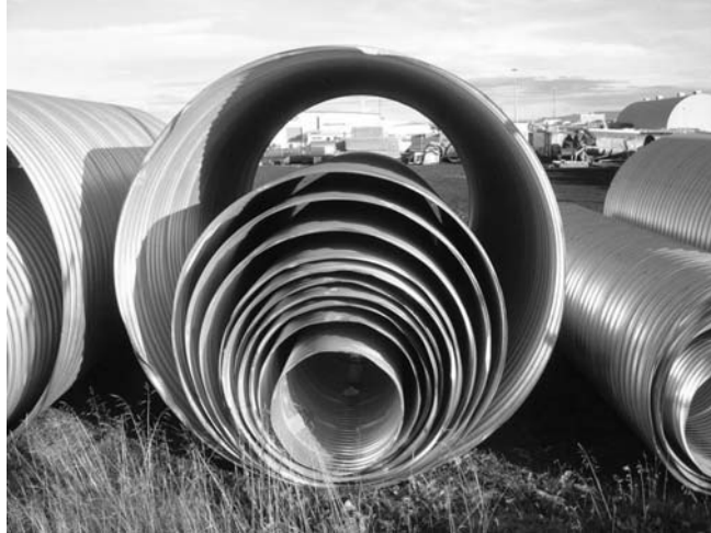
Ræsarörum raðað saman til þess að þau taki sem minnst pláss.
